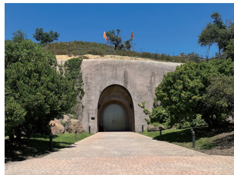
ジャービス・エステート玄関口
